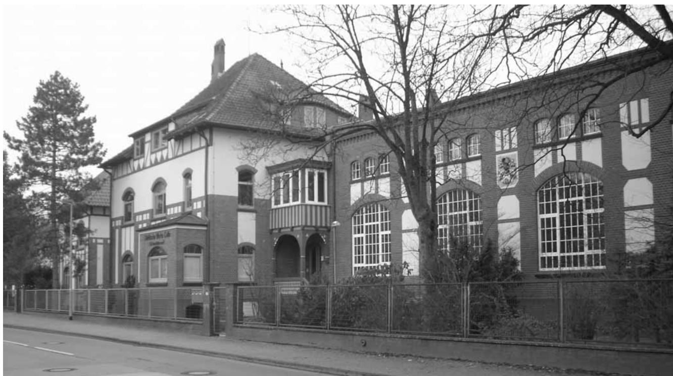
Ab 1906 wurde die Stadt vom »Städtischen Elektrizitätswerk« in der Hafenstraße mit Strom versorgt.
