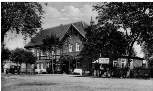
Gasthaus „Zur Linde“ im Groß-Hehlen der 1930er
