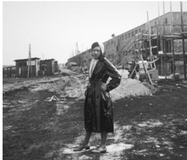
Auf der Baustelle Blumläger Feld - etwa 1930 , StA Celle
